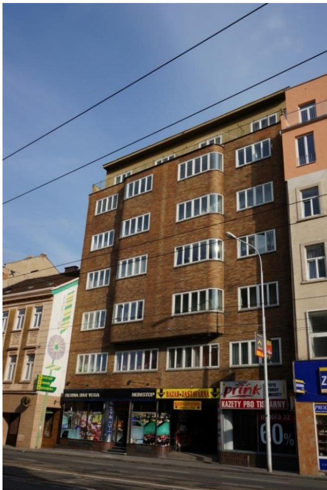
Façade of Křenová 14.
